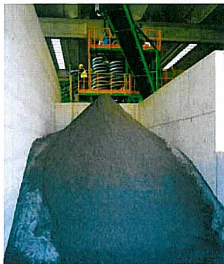
Nuovo impianto di Figino in provincia di Como.
