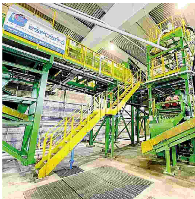
L'innovativo impianto «trasforma rifiuti» creato da Esposito in Irpinia
